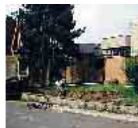
CASTELSANGIOVANNI - I lavori eseguiti in via Sauro
