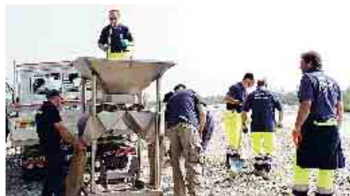
PODENZANO - Un momento delle prove: la tramoggia usata per i sacchetti di sabbia
