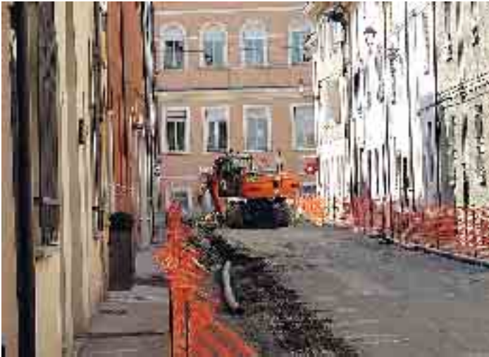
CASTELSANGIOVANNI - Il cantiere aperto lungo via Nino Bixio (foto Bersani)
