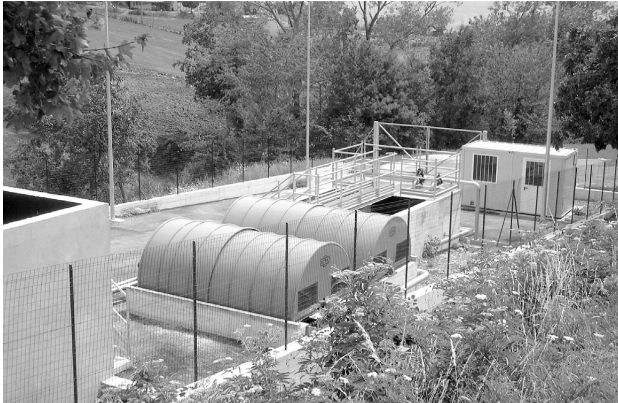
L'impianto di depurazione di Santa Maria di Bobbio
