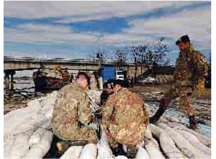
Pontieri impegnati nella posa delle panne assorbenti usate nel Po (foto Ferreri)
