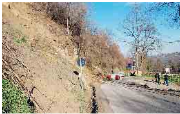
VERNASCA - La frana che si è staccata a Vigoleno occupando la strada (f. Lunini)
