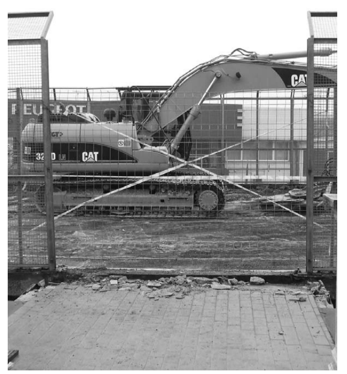
I lavori per il nuovo ponte sul Po, a pochi metri dalle abitazioni di via XXI Aprile dove i disagi sono moltissimi
