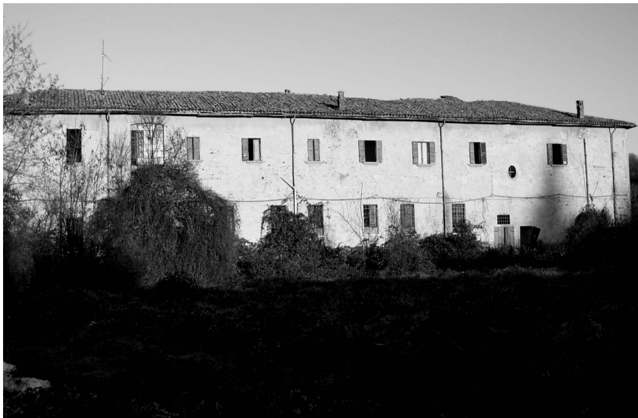
Nella foto, l'ex monastero di Monte Oliveto di Castellarquato
