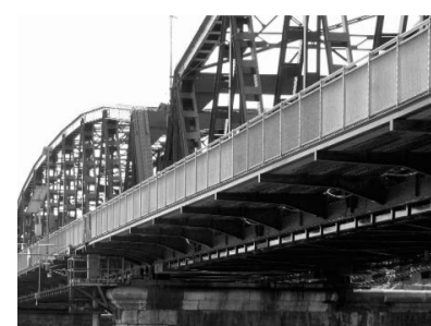
Il ponte in ferro sul Po
